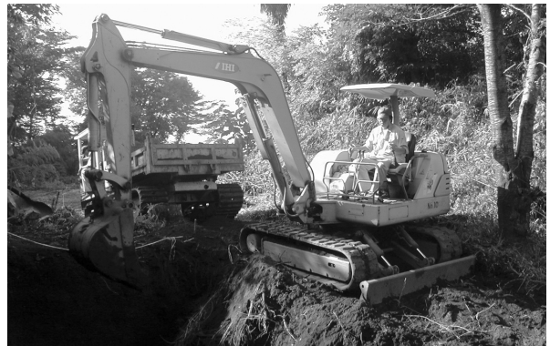
写真44 表土除去作業風景
