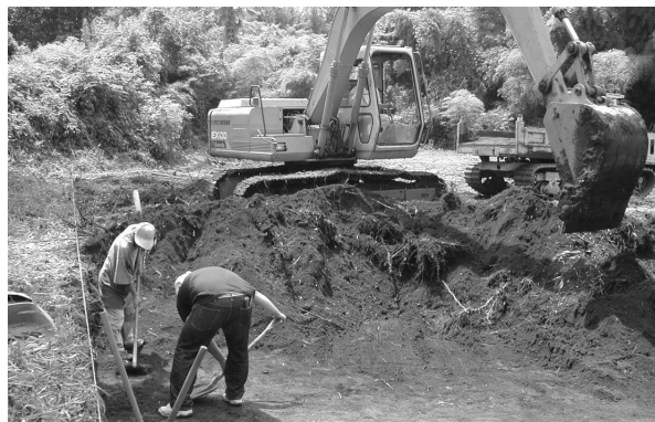
写真4 表土除去作業風景
