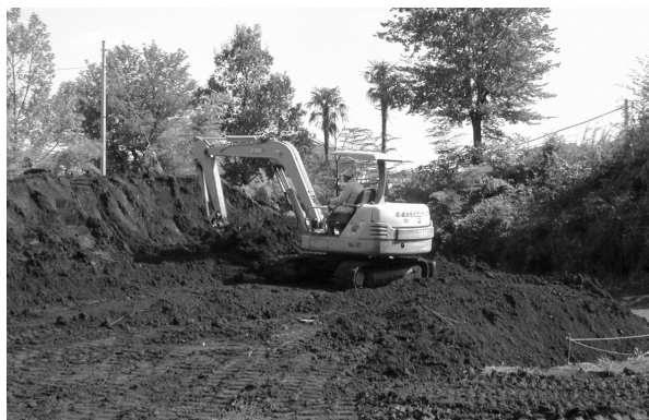
写真71 埋め戻し作業風景
