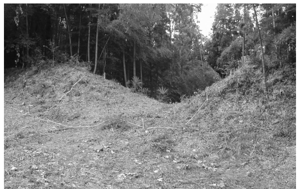
写真64 C区作業前全景
