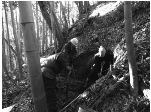
写真35 掘削作業風景
