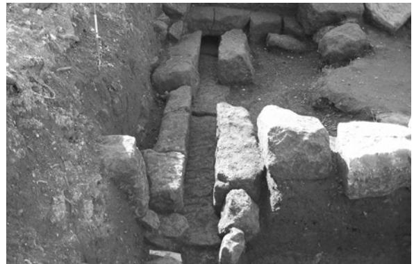
写真44 暗渠の蓋石を撤去後（東より）
