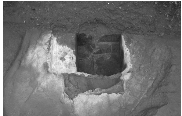
写真6 コンクリート地下構造物（東より）
