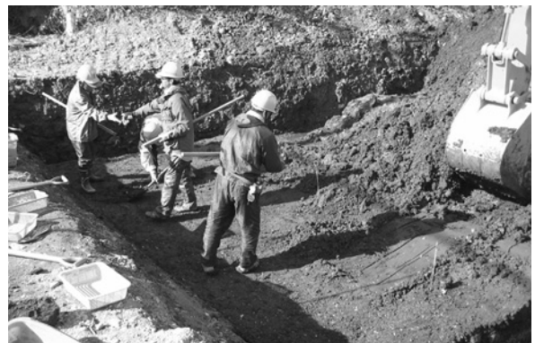
写真60 南西より表土除去風景
