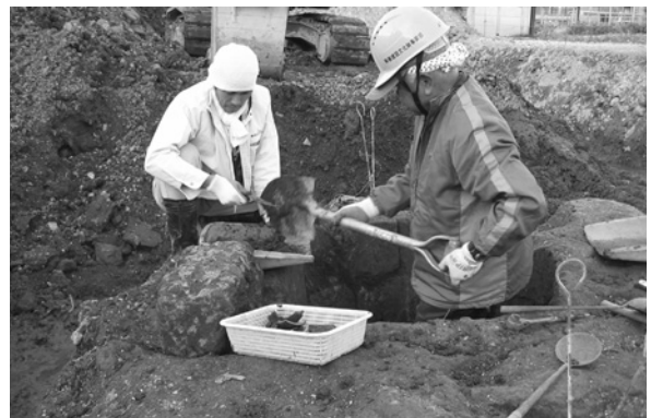
写真62 井戸掘削風景（上部）
