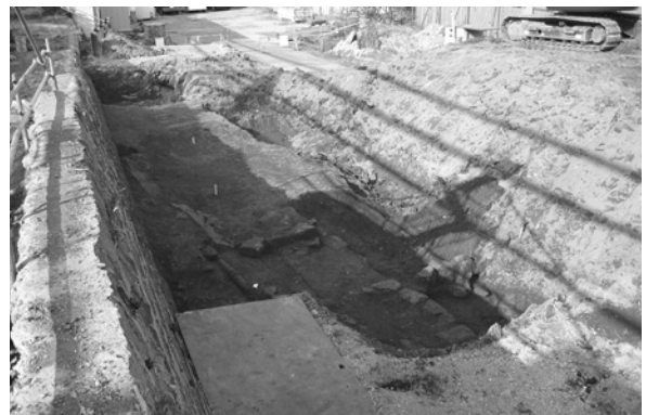
写真30 擁壁外遺構確認後（南西より）
