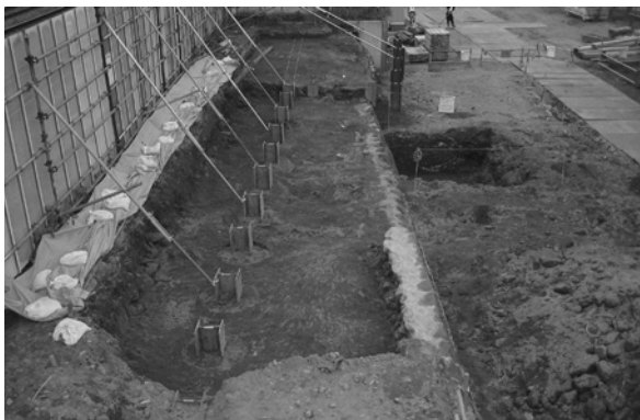
写真29 京浜急行擁壁部分表土除去後（南より）
