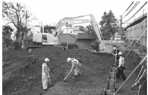
写真28 表土除去風景
