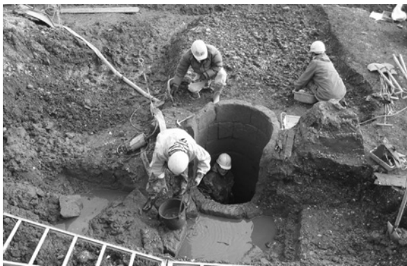
写真63 井戸掘削風景（下部）
