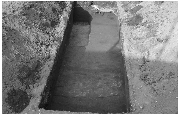
写真12 5トレンチ地業面 (西より)
