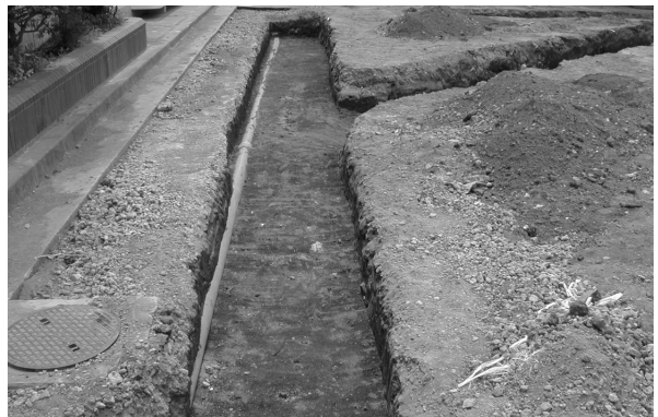
写真54 19トレンチ (東より)
