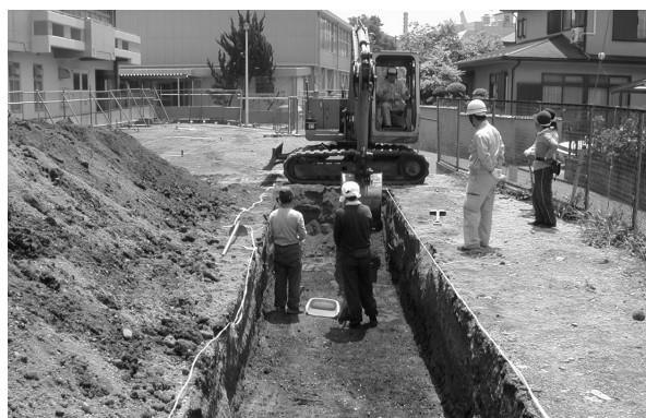
写真4 表土除去作業風景
