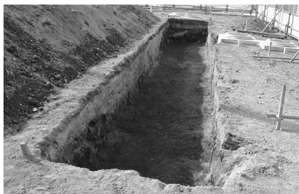
写真8 2トレンチ（南東より）
