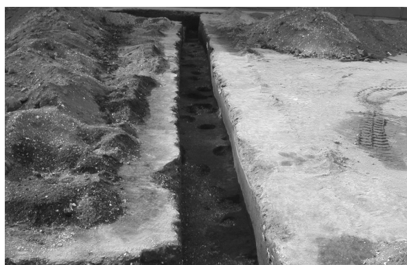
写真66 22トレンチ完掘状況（南より）
