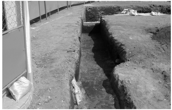
写真42 13トレンチ西側（南より）
