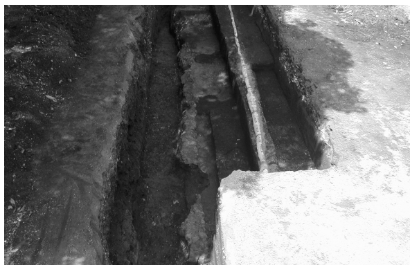
写真39 12トレンチ東側 (東より)
