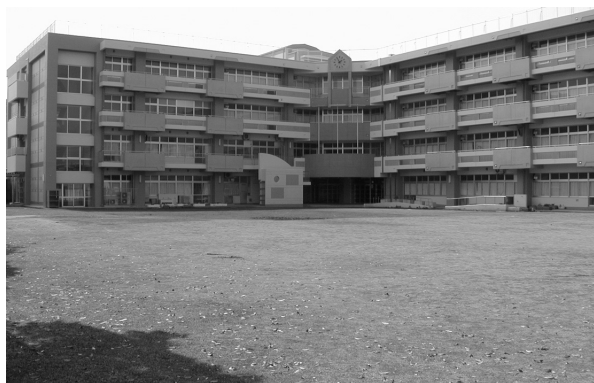
写真1 校庭部分調査前全景（北東より）
