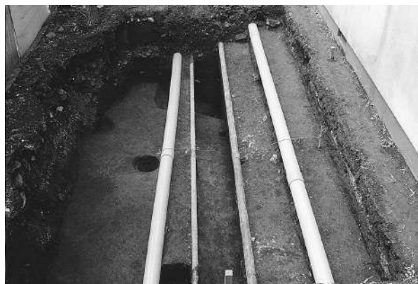
写真10 第1次1区掘削後全景(南西より)
