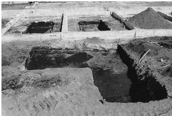
写真21 6・11・15T掘削状況(南南東より)
