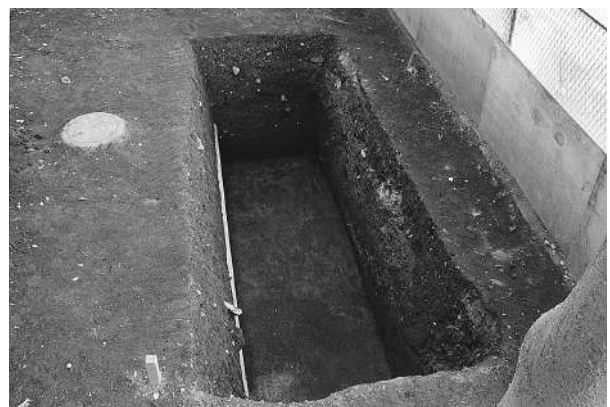
写真17 第1次5区掘削状況(東北東より)
