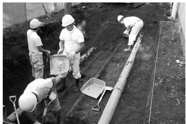
写真2 第1次1区掘削風景（西より）
