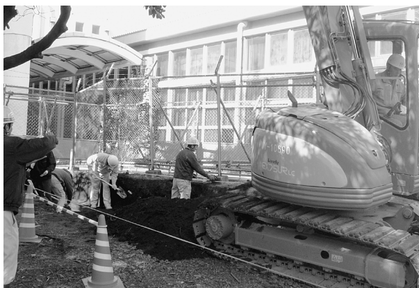
写真3 表土除去作業
